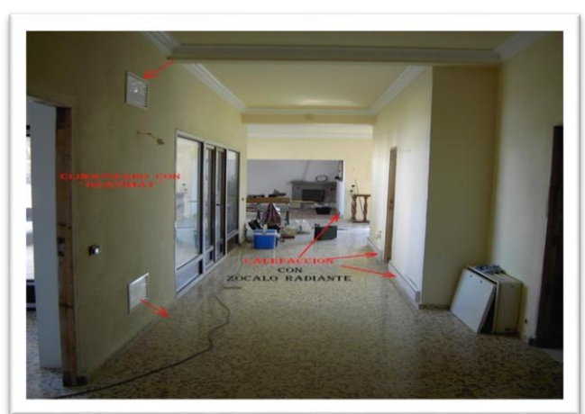
Instalación por gravitación y zócalo radiante
