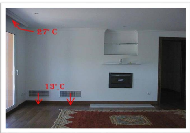
Instalación por gravitación
