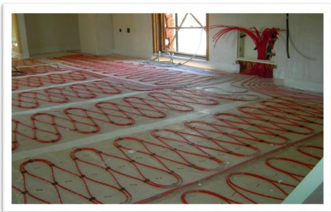
Instalación de suelo radiante
